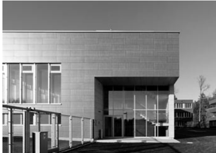
Eingang des Massnahmenzentrums Bitzi
